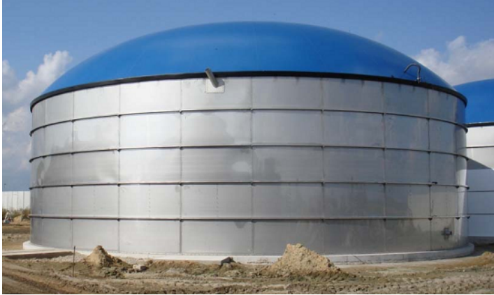
Abb. 4: Behälter mit Doppelmembrandach
