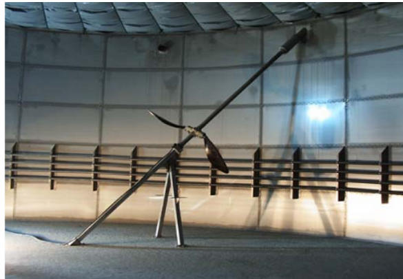
Abb. 5: Tauchmotorrührwerk (links) und Langachsenrührwerk (rechts)
